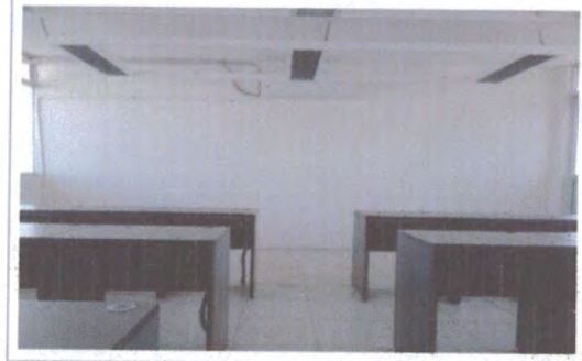
F4: Vista del interior de una aula terminada en el tercer nivel
