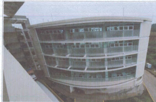
F2: Edificio A: Fachada Interior
