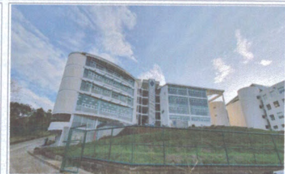
F5: Edificio C: Fachada Posterior
