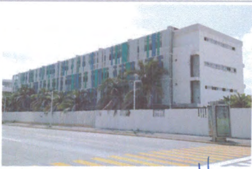
F3: FACHADA EDIFICIO A
