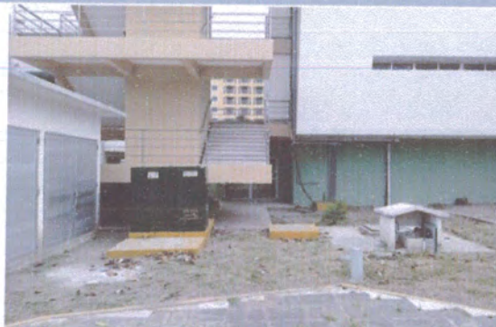
F2: En esta fotografía se observa que el transformador de 500 KVA ya fue instalado sobre la base prefabricada. A la izquierda de la foto se observa el cuarto de tableros ya terminado, solo esperando la aplicación de la pintura exterior.
