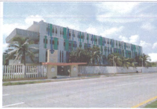
F1: FACHADA EDIFICIO A
