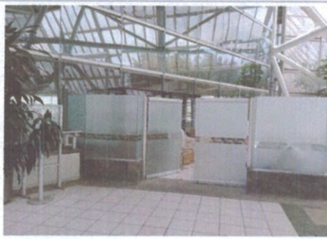
F4: Vista del acceso
