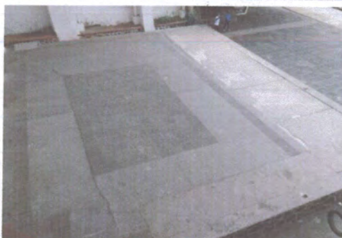
F1: Vista de la superficie del foro abierto
