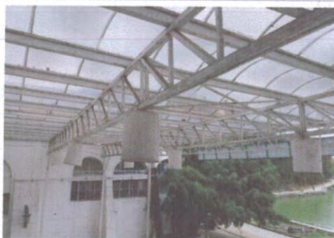
F2: Estado actual de la estructura
