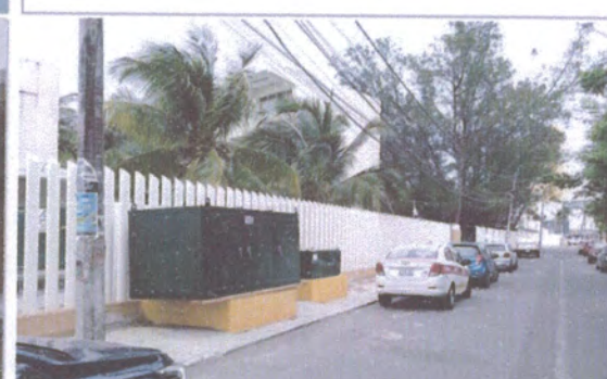
F5: Bases de concreto ya terminadas y transformador y equipo de medición ya montados sobre ellas.
