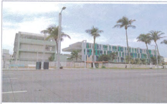
F4: FACHADA EDIFICIO A
