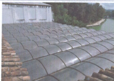
F4: Estado actual cubierta foro abierto
