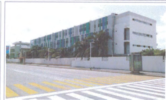
FOTO 5: FACHADA EDIFICIO A
