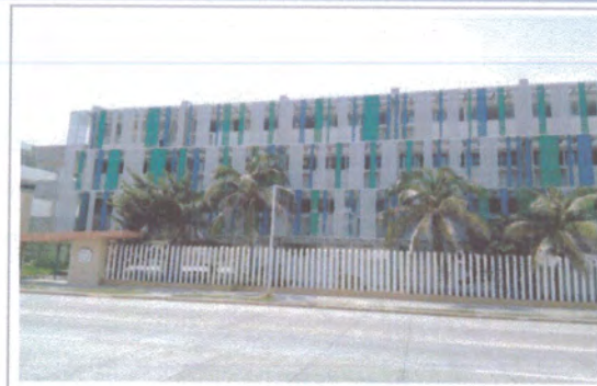
F2: FACHADA EDIFICIO A
