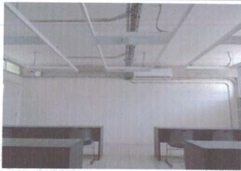
F1: Vista del interior de una aula terminada en el segundo nivel
