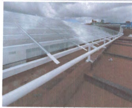
F4: Vista desde azotea 2
