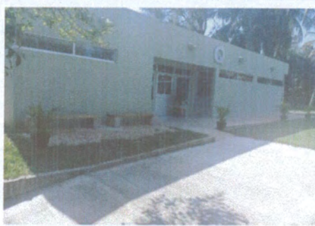
F4: Vista lateral exterior
