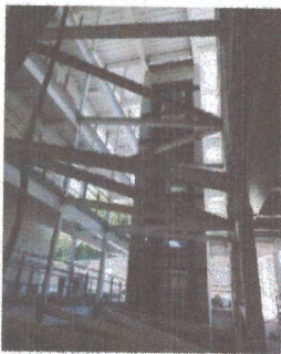
F3: Cimentación Cubo del elevador
