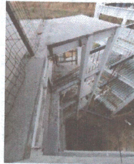
F2: Estructura escaleras
