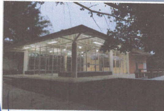
F4: Vista de la cafetería actual
