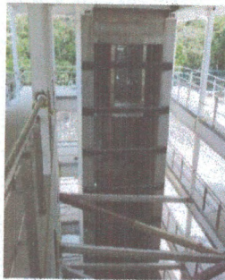
F3: Cimentacion Cubo del elevador
