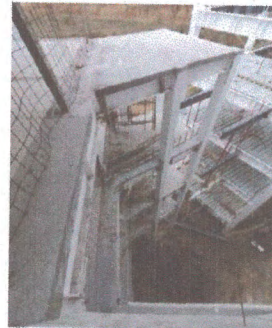
F2: Estructura escaleras
