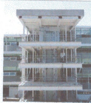
F4: Fachada posterior (cubo del elevador)
