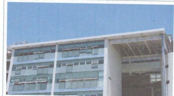
F5: Fachada principal cubo de escaleras y rampa
