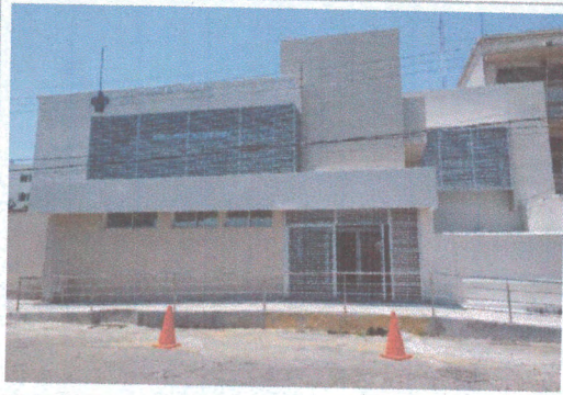
F1: Fachada principal
