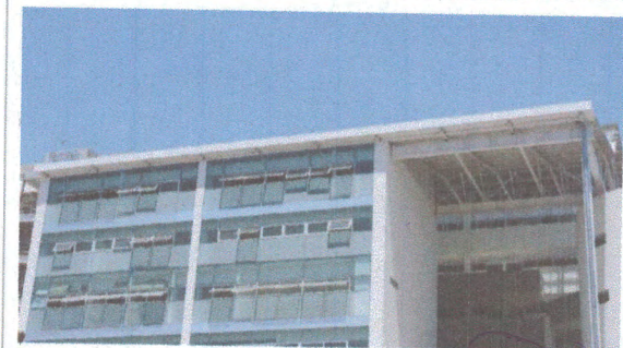
F5: Fachada principal-cubo de ascensor y rampa
