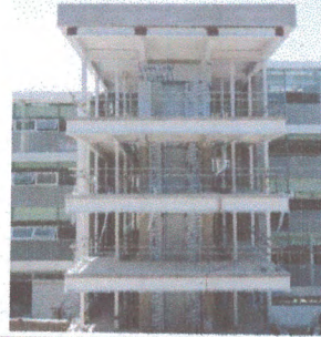
F4: Fachada posterior (cubo del elevador)
