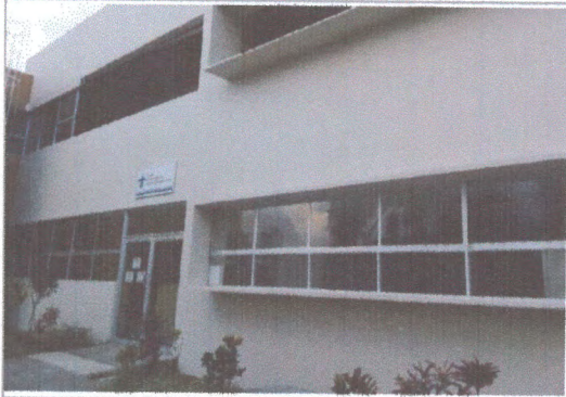
F1: Fachada principal
