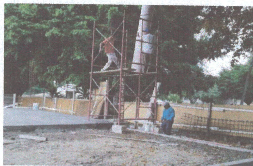
F2: Vista del estacionamiento
