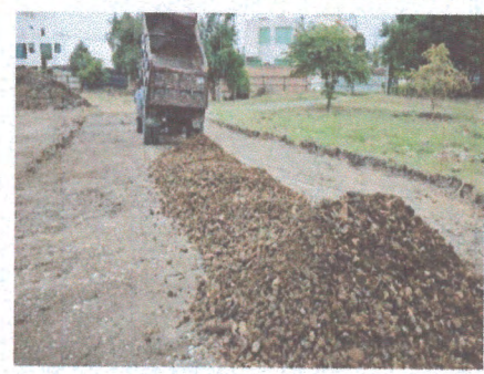
F3: Vista del estacionamiento
