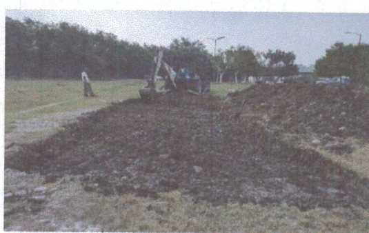
F2: Vista del estacionamiento
