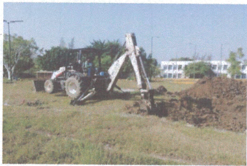
F1: Vista del estacionamiento
