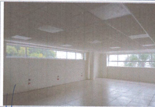
F4: Vista general primer nivel Posgrados
