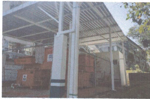
F2: Vista posterior de la planta de tratamiento
