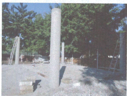
F3: Vista del estacionamiento
