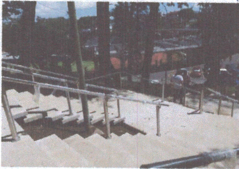
F1: VISTA GENERAL DESCENSO
