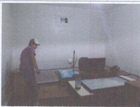
F3: MANTENIMIENTO DE PINTURA EN INTERIORES
