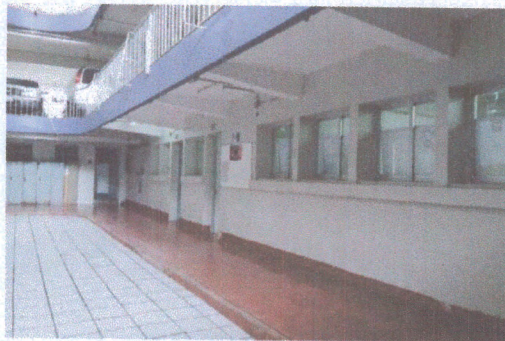
F2: MANTENIMIENTO DE PINTURA
