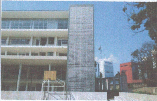
F1: Fachada principal
