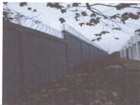
F4: VISTA POSTERIOR DEL EDIFICIO, CERCADO PERIMETRAL
