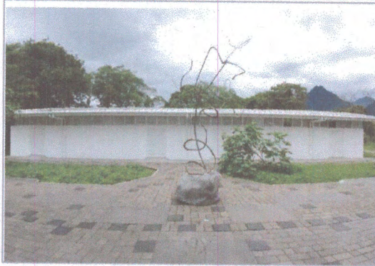
F1: Fachada principal
