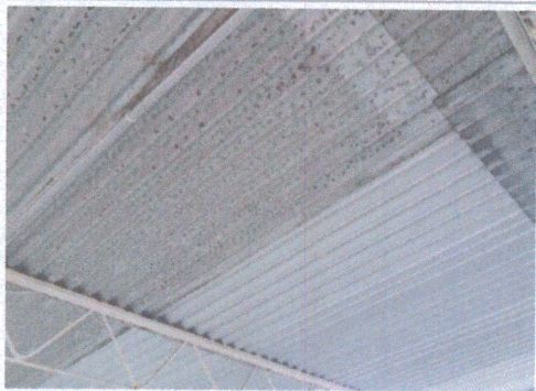
F1: SUSTITUCIÓN PARCIAL DE LÁMINA METÁLICA
