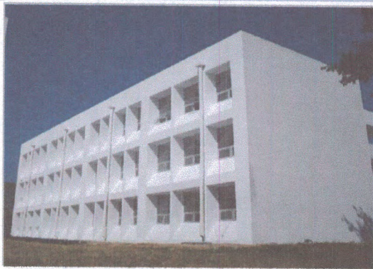
F1: Fachada principal
