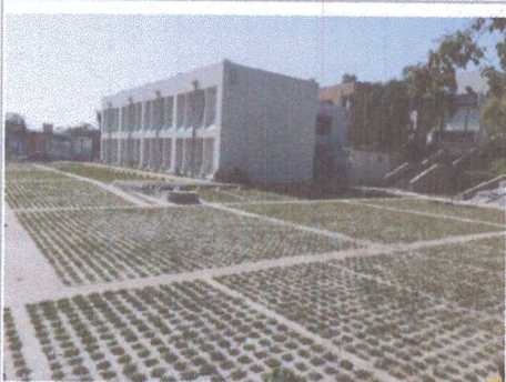
F3: VISTA HACIA EL ÁREA DE ESTACIONAMIENTO
