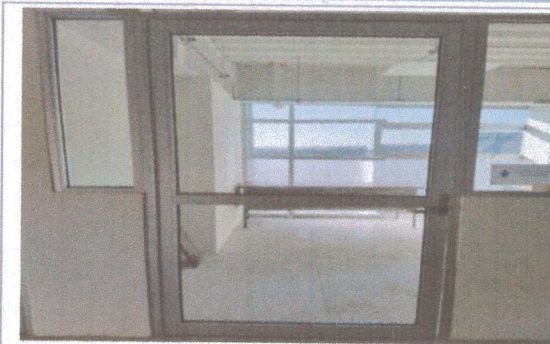
F2: Cubículos último nivel Edificio B
