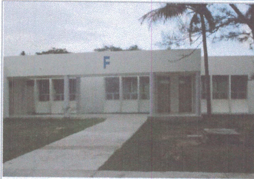
F1: Fachada principal
