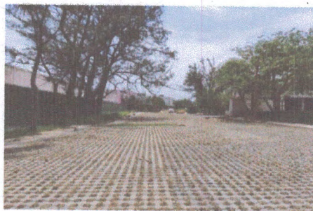
F3: VISTA DE AMPLIACIÓN DE ESTACIONAMIENTO
