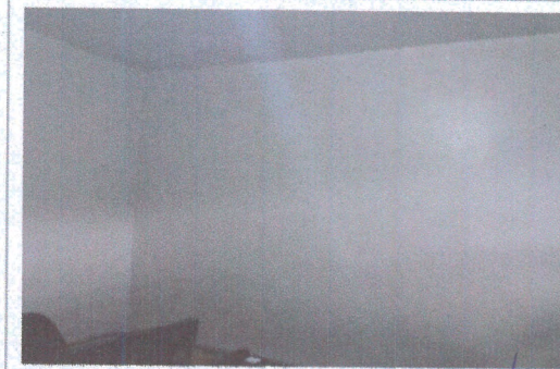
F5: MANTENIMIENTO DE PINTURA EN INTERIORES
