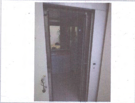
F3: PUERTA DE ACCESO
