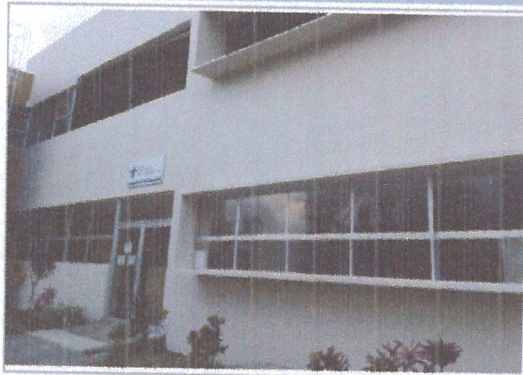
F1: Fachada principal
