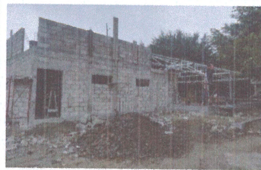
F4: Vista de la cafetería actual
