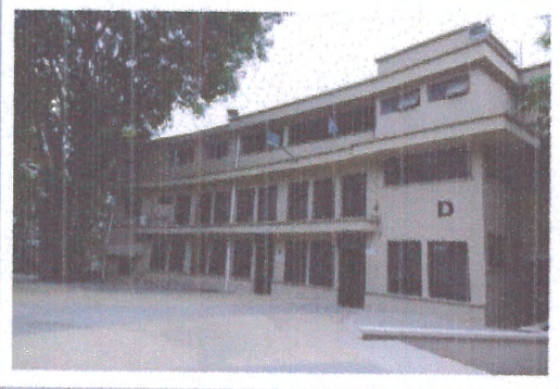
F1: Fachada principal
