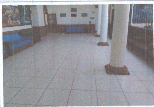
P1: VISTA GENERAL VESTIBULO 1
