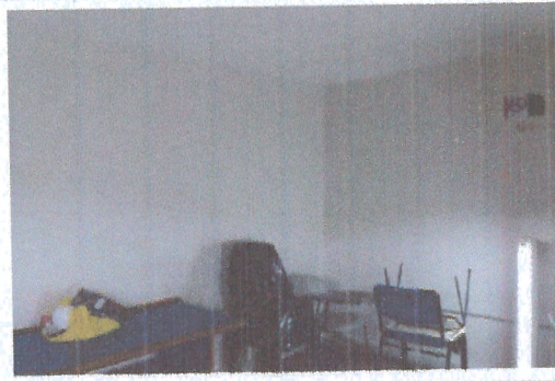
F4: MANTENIMIENTO DE PINTURA EN INTERIORES
