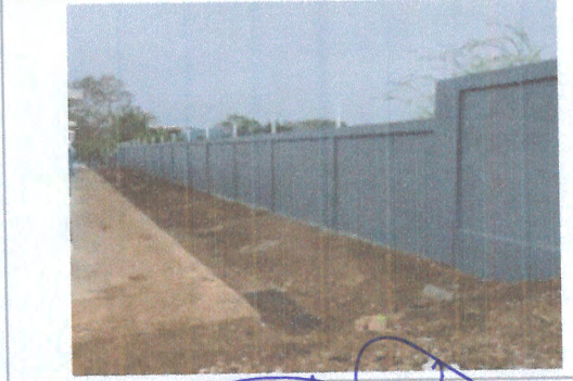
F5: VISTA LATERAL DEL MURDO CERCADO
