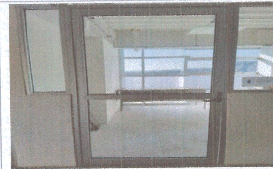
F2: Cubículos último nivel Edificio B
