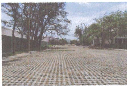
F3: VISTA DE AMPLIACIÓN DE ESTACIONAMIENTO
