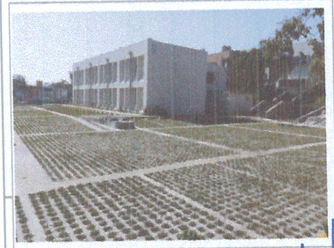
F3: VISTA HACIA EL AREA DE ESTACIONAMIENTO
