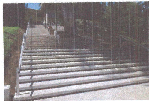
F4: VISTA GENERAL ASCENSO 1
