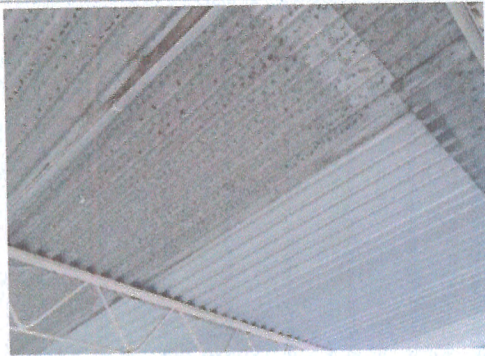
F1: SUSTITUCIÓN PARCIAL DE LÁMINA METÁLICA
