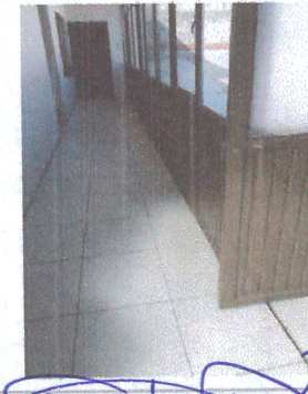
P5: VISTA GENERAL FONDO DE ACCESO
