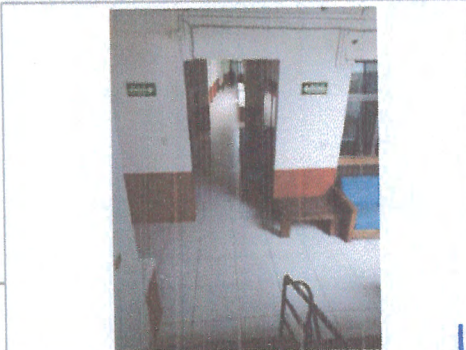
P3: INTERIOR ADMINISTRACION 1
