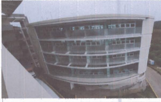
F2: Edificio A. Fachada Interior
