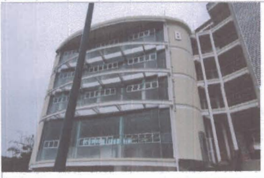
F1: Edificio A y E. Fachada Posterior
