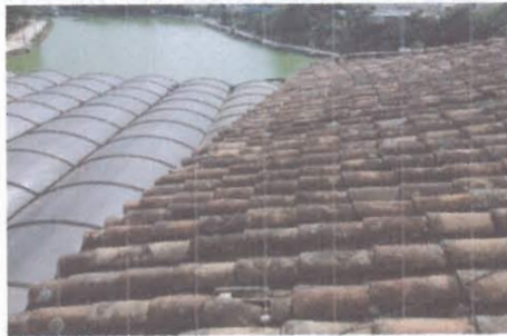
F3: Estado actual intersección de cubiertas
