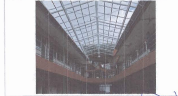
P5: Vista general de la obra
