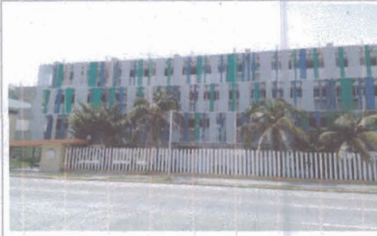
F2: FACHADA EDIFICIO A
