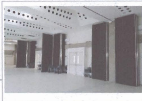
P3: SONOMUROS EN SALA DE VIDEOCONFERENCIAS
