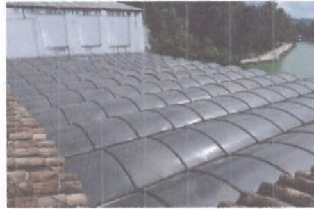
F4: Estado actual cubierta foro abierto
