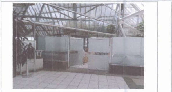
F4: Vista del acceso
