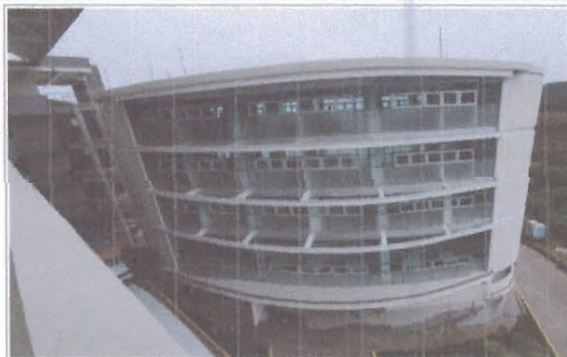
F2: Edificio A: Fachada Interior
