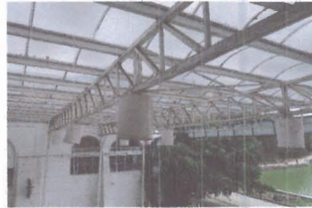
F2: Estado actual de la estructura
