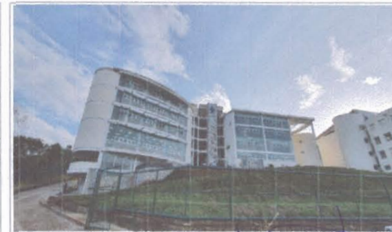
F5: Edificio C: Fachada Exterior
