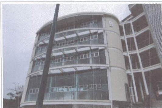
F1: Edificio A y E: Fachada Posterior
