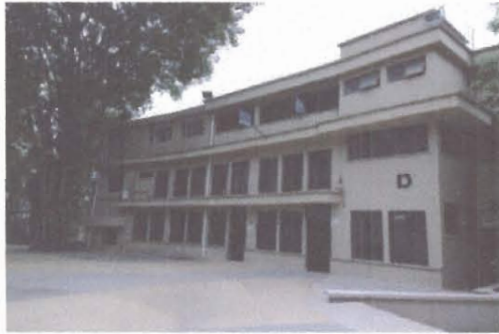
F1: Fachada principal
