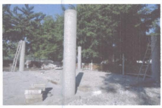
F4: Vista de la cafetería actual
