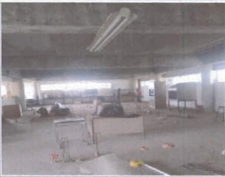
F3: vista general primer nivel
