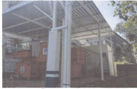
F2: Vista posterior de la planta de tratamiento
