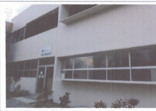
F1: Fachada principal
