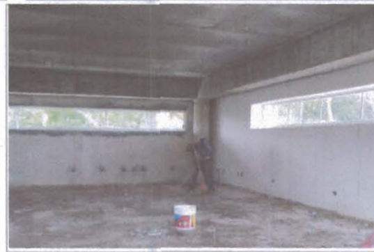
F4: Vista general primer nivel
