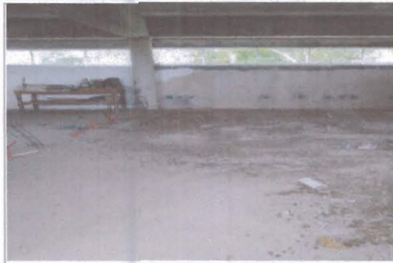
F2: Primer Nivel laboratorios
