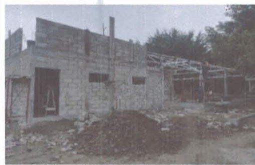
F4: Vista de la cafetería actual
