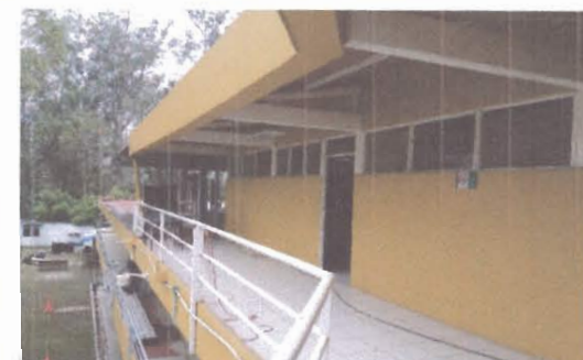
F5: Vista desde escaleras
