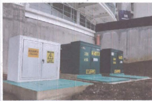
F1: Edificio (B) Entrada principal
