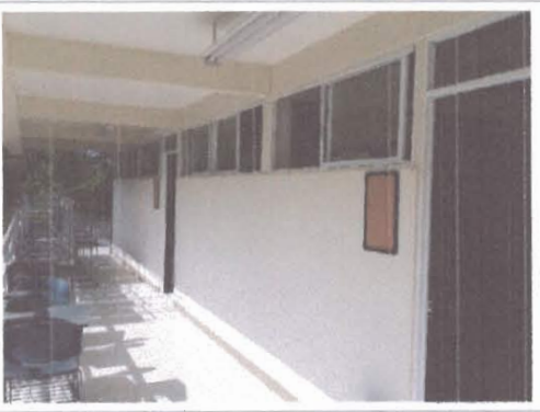
F1: Vista del acceso
