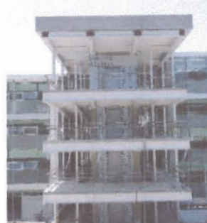
F4: Fachada posterior (cubo del elevador)
