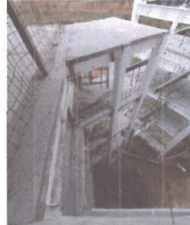
F2: Estructura escaleras
