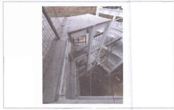
F2: Estructura escaleras
