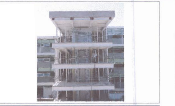
F4: Fachada posterior (cubo del elevador)
