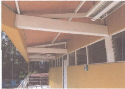
F1: vista del acceso
