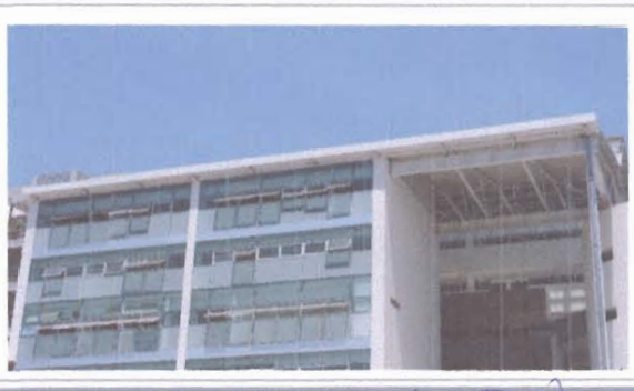
F5: Fachada principal cubo de escaleras y rampa
