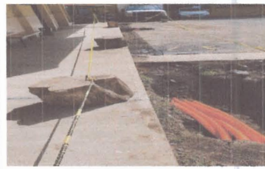
F4: Fachada lateral
