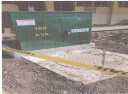
F1: Fachada lateral
