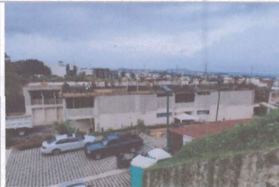
F2: Fachada lateral izquierda
