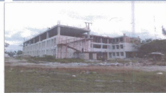
F4: Fachada Oeste (segundo nivel)
