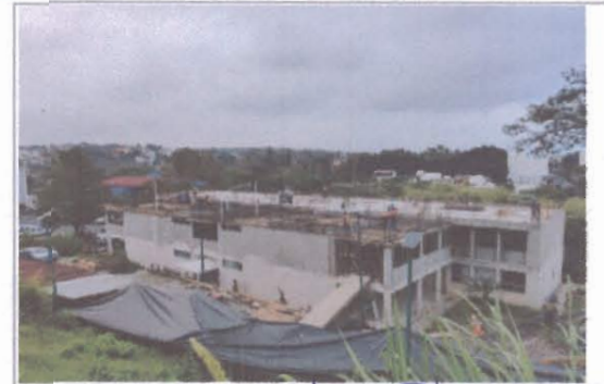
F5: Fachada lateral
