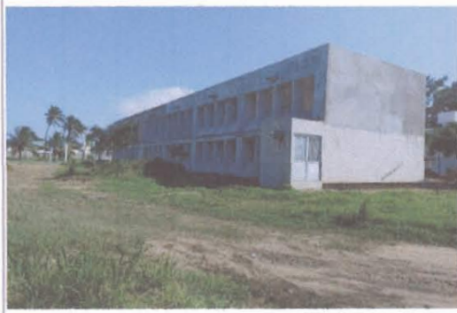
F1: Fachada principal
