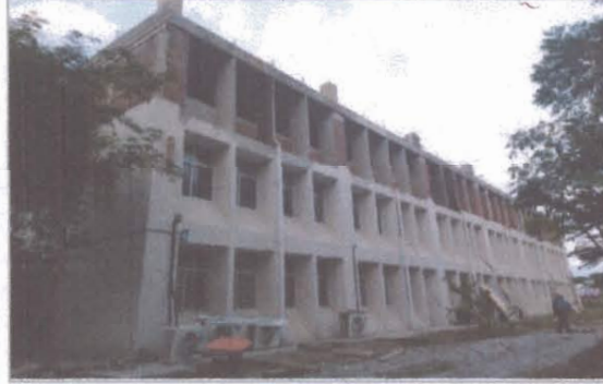
F1: Fachada norte (segundo nivel)
