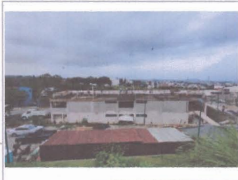
F3: vista general de edificio
