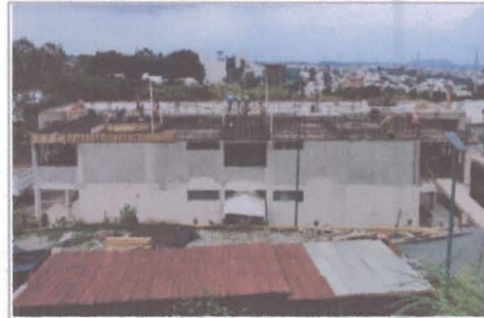
F4: fachada lateral izquierda
