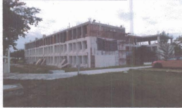
F2: Fachada este (segundo nivel)
