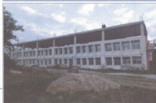
F3: Fachada Sur (segundo nivel)
