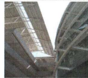
F5: Fachada cubo de escalera y rampa
