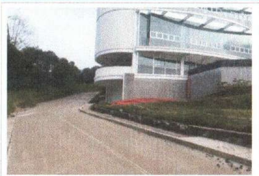
F1: Edificio (B) Entrada principal
