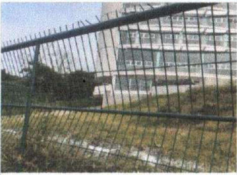
F3: Edificio (B) Transformadores
