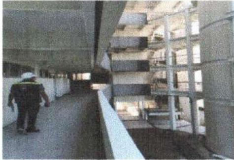
F1: Edificio (B): Rampa entre edificio B y C
