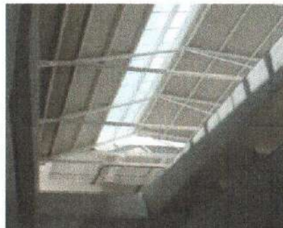
F4: Cubo de escaleras
