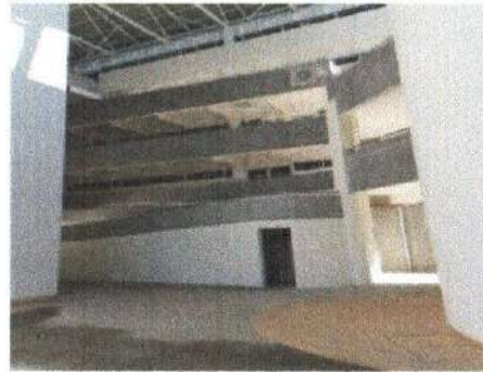
F2: Rampa edificio B
