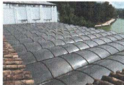
P4: Estado actual cobertizo foro abierto
