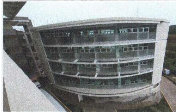
F2: Edificio A: Fachada Interior
