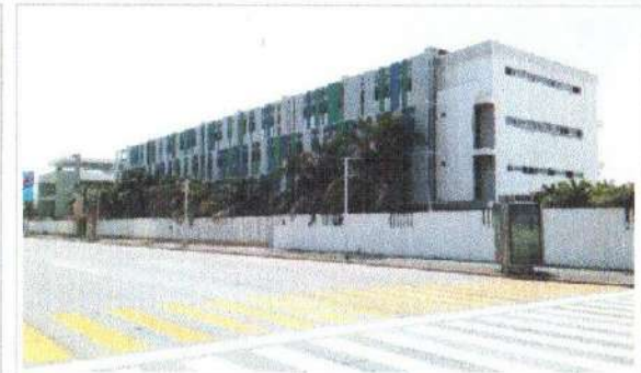
FOTO 5: FACHADA EDIFICIO A
