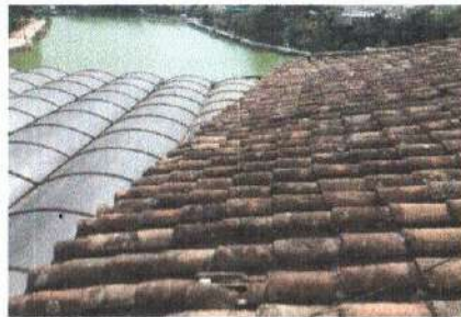
P3: Estado actual instalación de cobertizo
