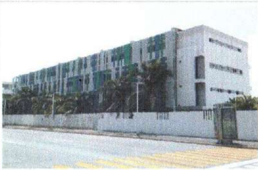
F3: FACHADA EDIFICIO A
