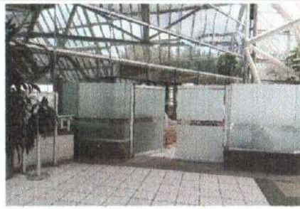
F4: Vista del acceso
