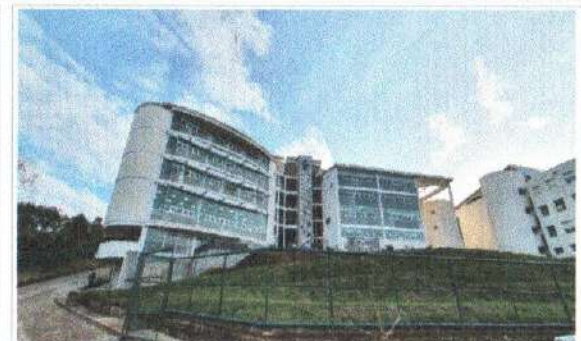
F5: Edificio C: Fachada Posterior
