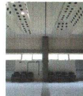
F5: SONOMUROS EN SALA DE VIDEOCONFERENCIAS
