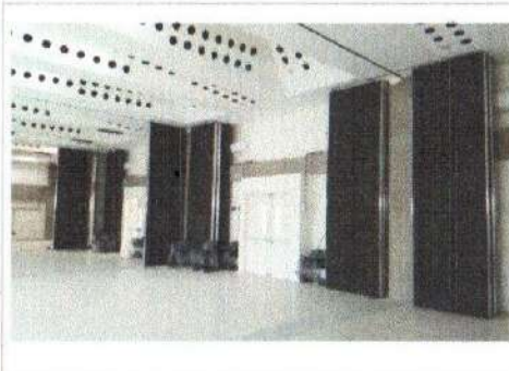
F3: SONOMUROS EN SALA DE VIDEOCONFERENCIAS
