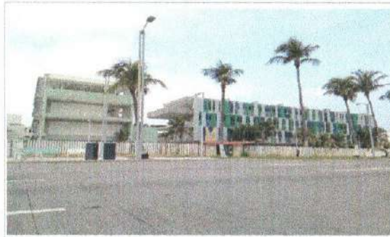
F4: FACHADA EDIFICIO A
