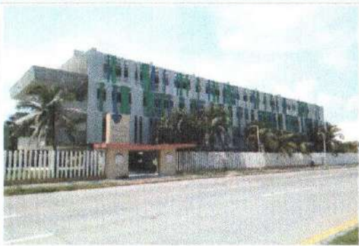
F1: FACHADA EDIFICIO A
