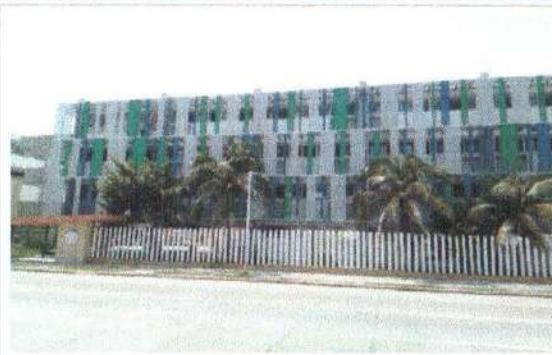
F2: FACHADA EDIFICIO A
