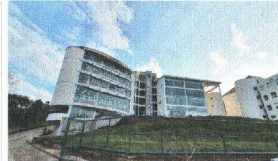
F5: Edificio C: Fachada Posterior
