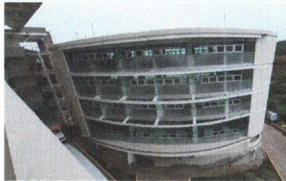
F2: Edificio A: Fachada Interior
