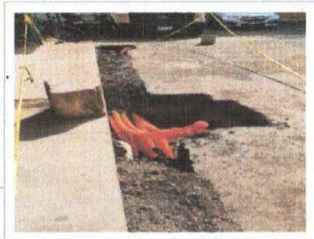
F2: Fachada lateral
