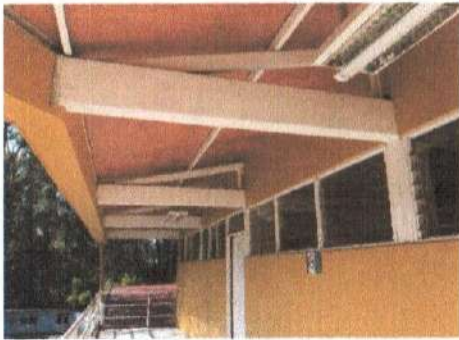
F1: vista del acceso
