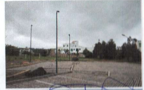
P5: Vista del estacionamiento
