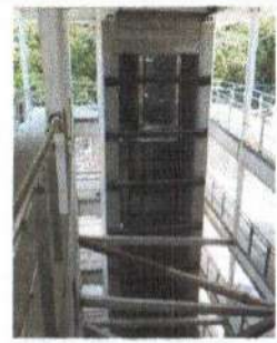
F3: Cimentación Cubo del elevador
