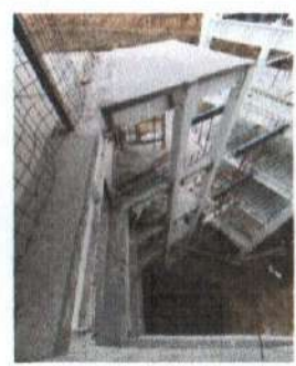
F2: Estructura escaleras
