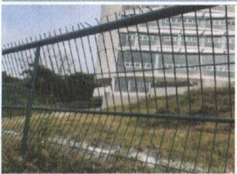
F3: Edificio (B) Transformadores
