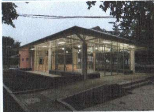
P1: Vista del Edificio A
