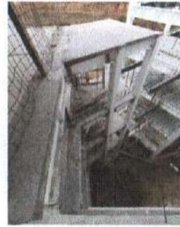
F2: Estructura escaleras
