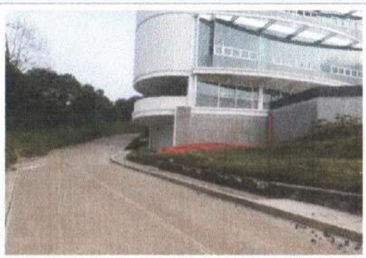
F1: Edificio (B) Entrada principal
