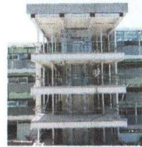
F4: Fachada posterior (cubo del elevador)
