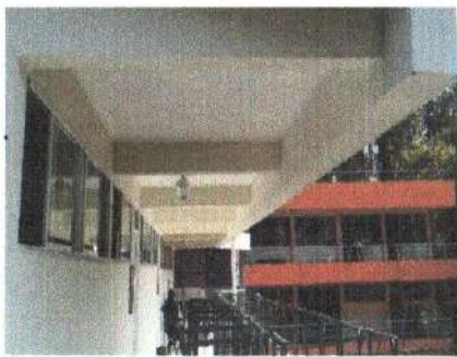
F3: Vista del pasillo
