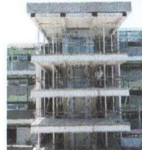
F4: Fachada posterior (dubo del elevador)
