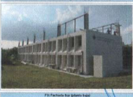
F3: Fachada Sur (planta baja)
