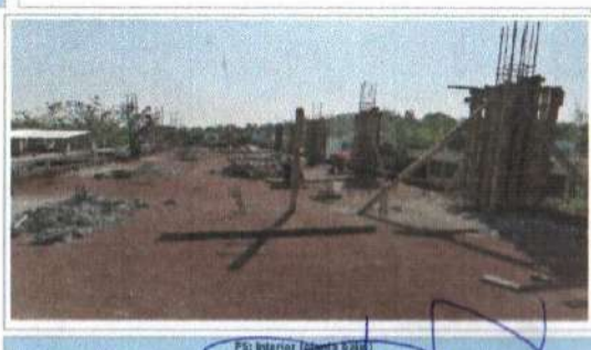
F5: Interior (planta baja)
