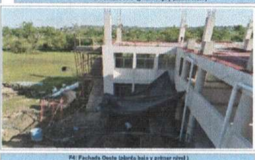
F4: Fachada Oeste (planta baja y primer nivel)
