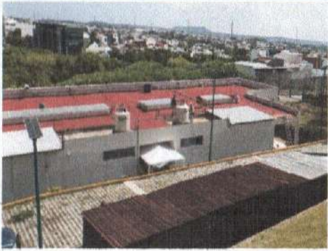
F3: vista general de edificio
