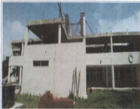
P3: Fachada posterior
