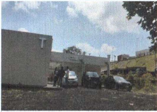
F1: Fachada principal
