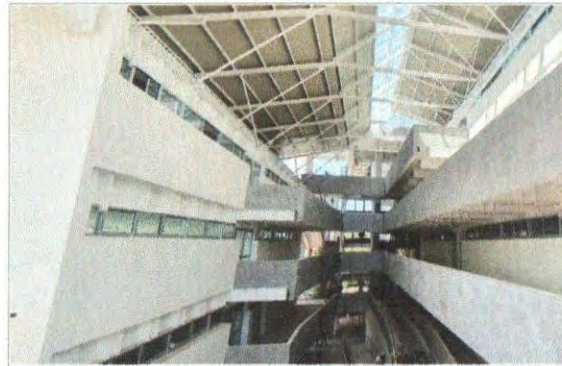
F2: Edificio A: Fachada Interior
