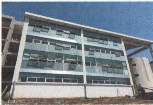
F1: Edificio A y E: Fachada Posterior
