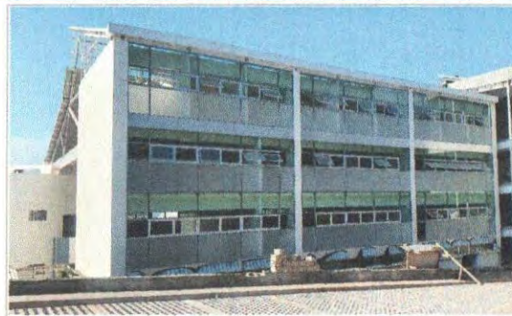
F4: Edificio D: Fachada Posterior
