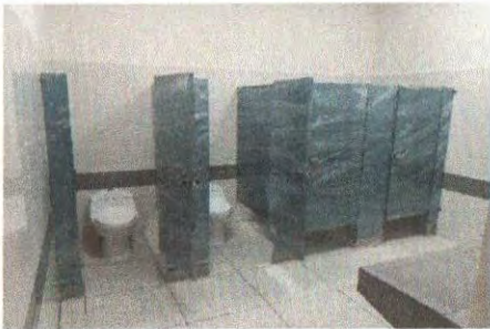
F3: Vista sanitarios
