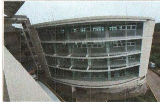
F2: Edificio A: Fachada Interior
