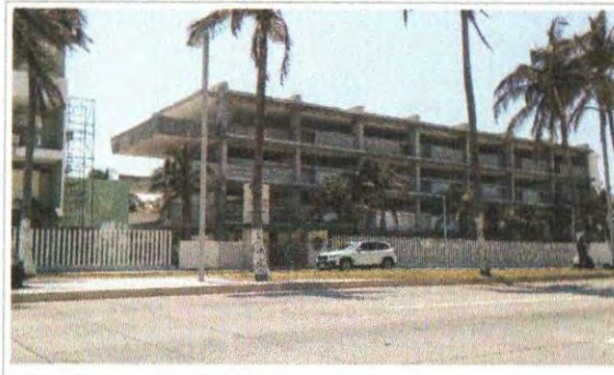
F4: FACHADA EDIFICIO A
