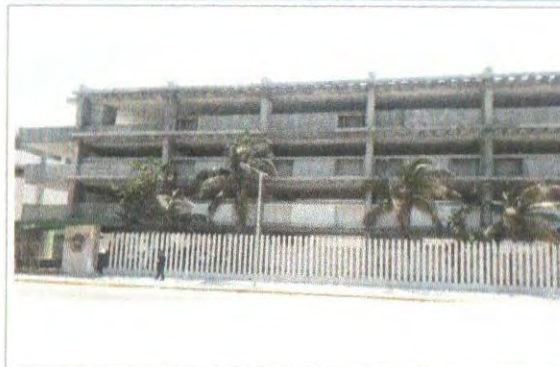
F2: FACHADA EDIFICIO A
