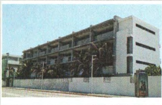
F3: FACHADA EDIFICIO A
