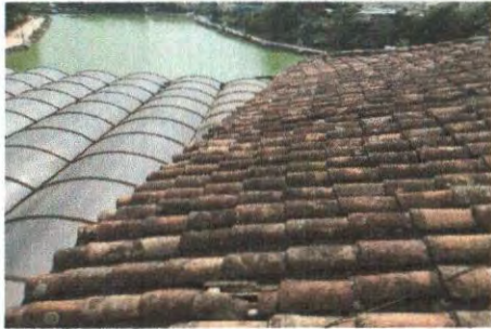
F3: Estado actual intersección de cubiertas
