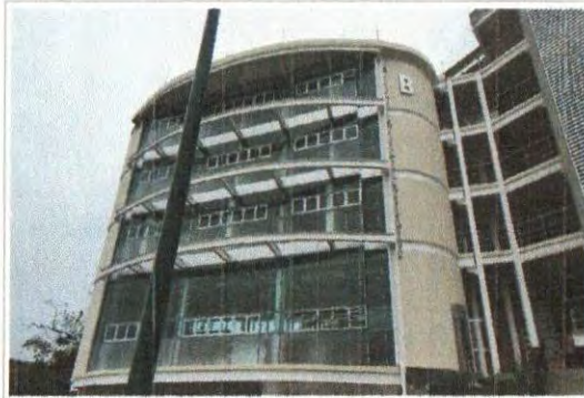
F1: Edificio A y E: Fachada Posterior
