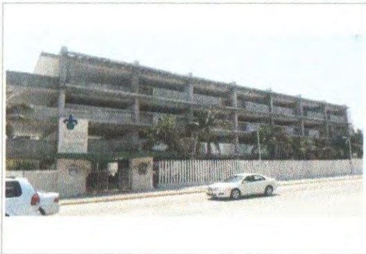
F1: FACHADA EDIFICIO A
