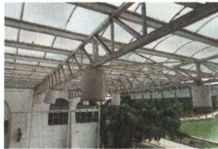
F2: Estado actual de la estructura
