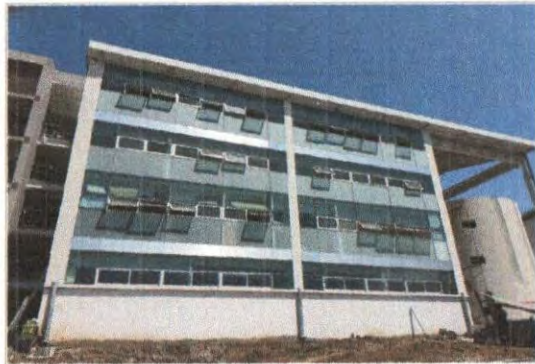
F1: Edificio A y E: Fachada Posterior
