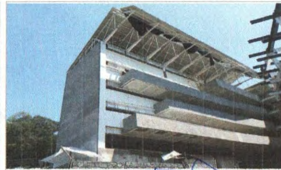
F5: Edificio C: Fachada Posterior
