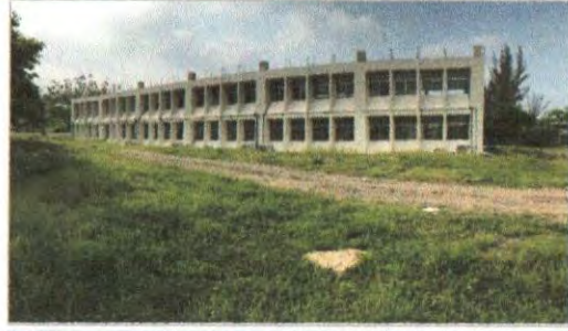
F4: Fachada Oeste (planta baja y primer nivel)
