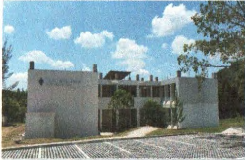
F1: Fachada norte (planta baja y primer nivel).
