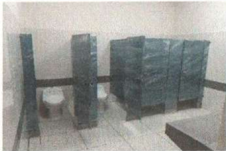
F3: Vista sanitarios
