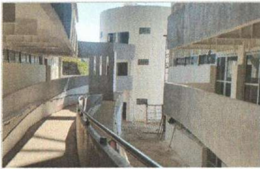
F3: Edificio E: Fachada Principal
