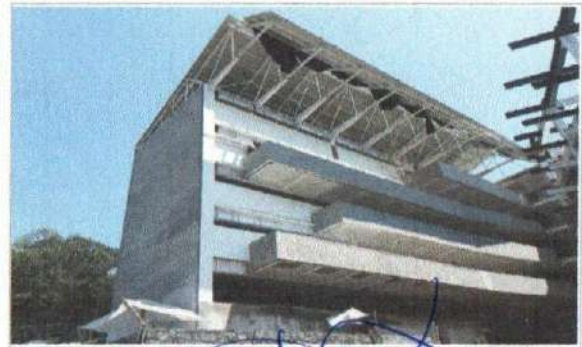
F5: Edificio C: Fachada Posterior
