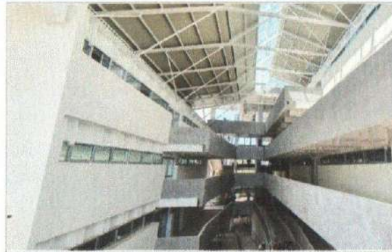
F2: Edificio A: Fachada interior
