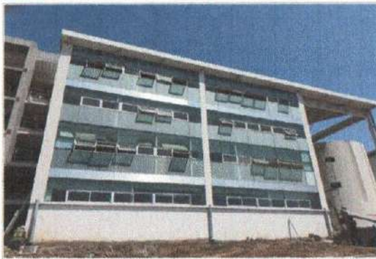
F1: Edificio A y E: Fachada Posterior
