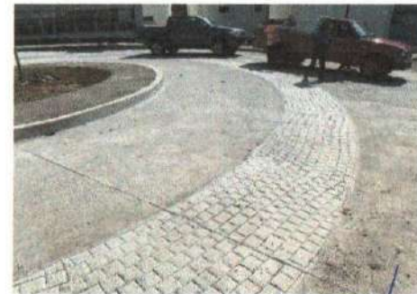
F5: VISTA DE ACCESO
