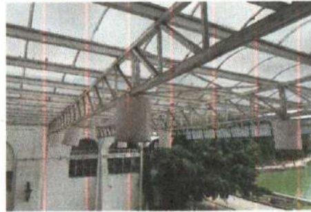
F2: Estado actual de la estructura
