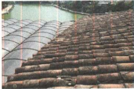
F3: Estado actual intersección de cubiertas
