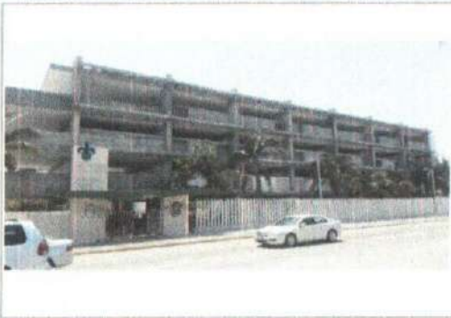
F1: FACHADA EDIFICIO A
