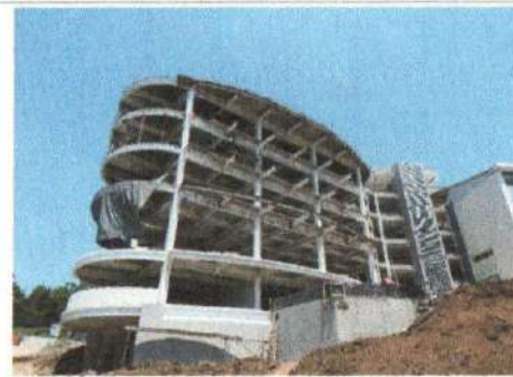
F5: VISTA DE ACCESO
