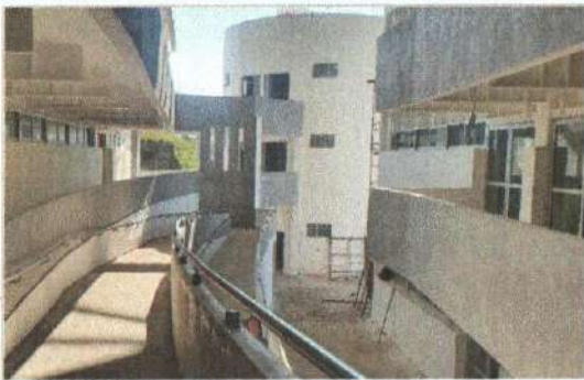
F3: Edificio E: Fachada Principal
