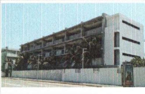
F3: FACHADA EDIFICIO A
