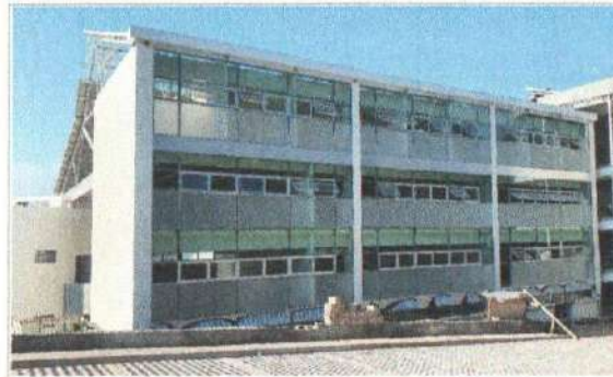
F4: Edificio D: Fachada Posterior
