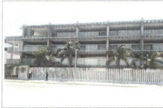
F2: FACHADA EDIFICIO A
