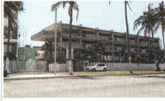
F4: FACHADA EDIFICIO A
