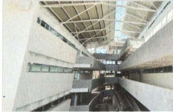
F2: Edificio A: Fachada Interior
