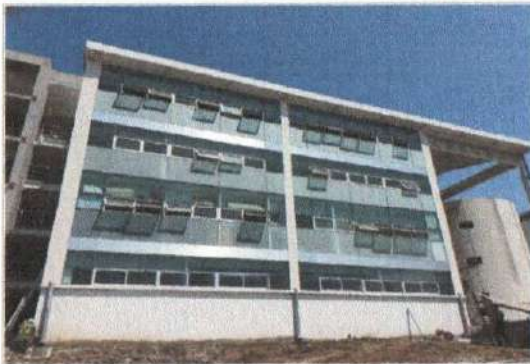
F1: Edificio A y E: Fachada Posterior
