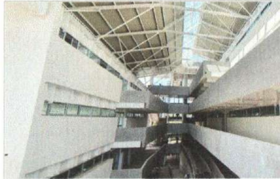
F2: Edificio A: Fachada Interior
