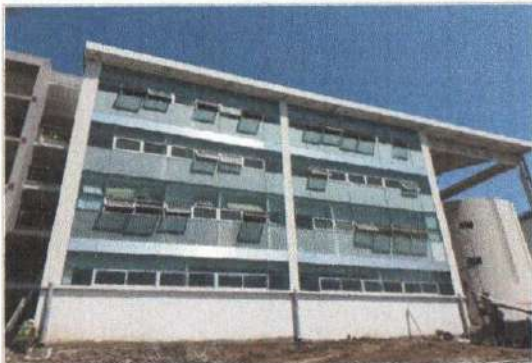
F1: Edificio A y E: Fachada Posterior
