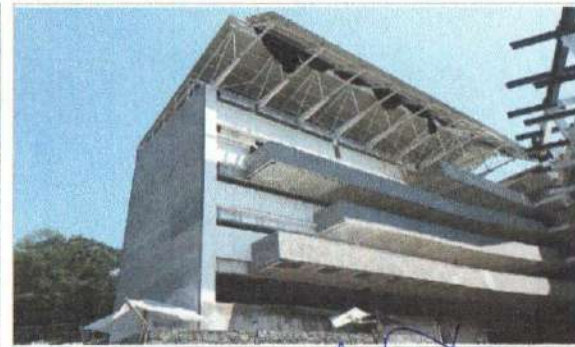
F5: Edificio C: Fachada Posterior
