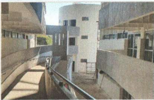
F3: Edificio E: Fachada Principal
