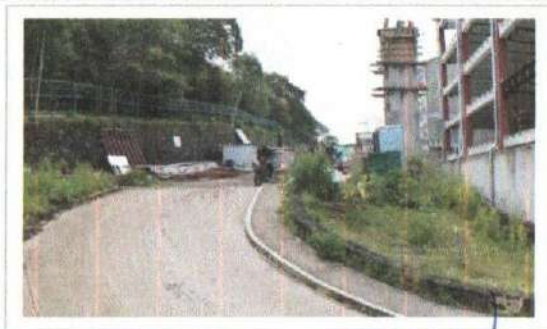
F5: VISTA DE ACCESO
