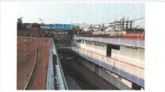
P1: Vista desde azotea 1
