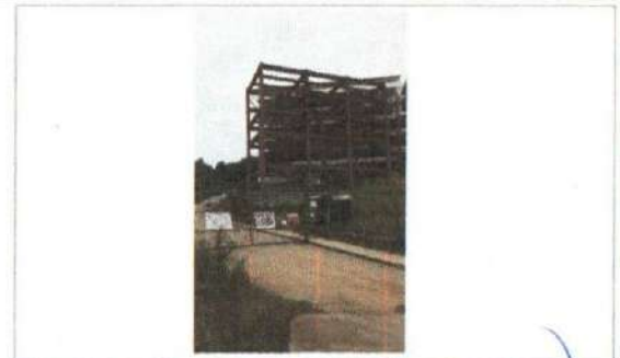
F5: VISTA DE ACCESO
