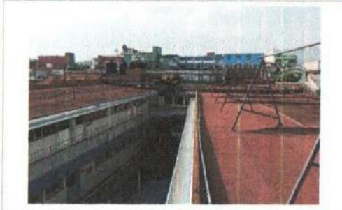
P4: Vista desde azotea 2
