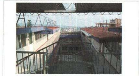
P5: Vista general del patio central
