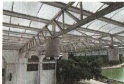
F2: Estado actual de la estructura
