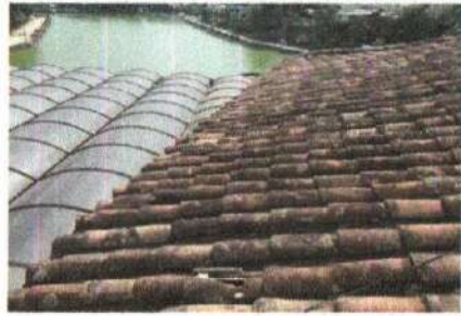
F3: Estado actual rehabilitación de cubierta
