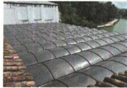
F4: Estado actual cubierta foro abierto
