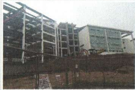
F1: Edificio A y E: Fachada Posterior
