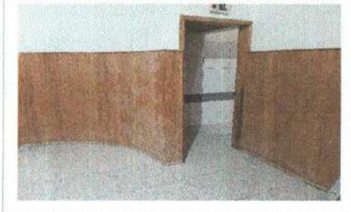
P4: Vista de pasillo interior
