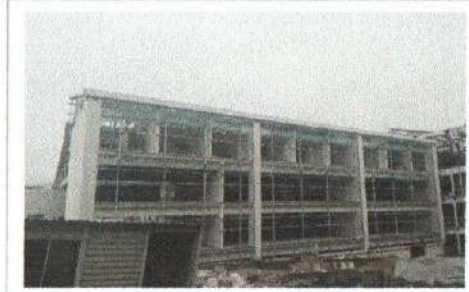
F4: Edificio D: Fachada Posterior
