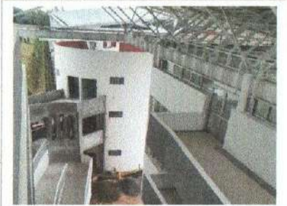
F3: Edificio E: Fachada Principal
