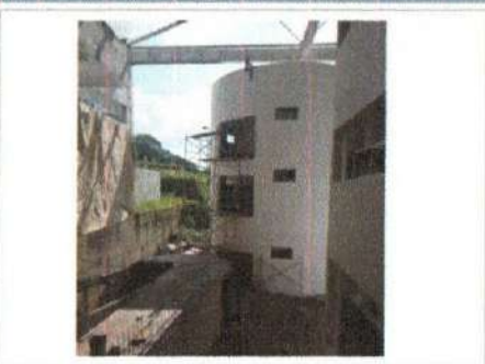
F3: Edificio E: Fachada Principal
