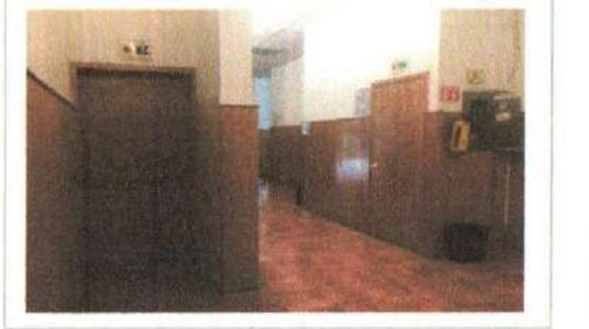
F4: Vista de pasillo interior
