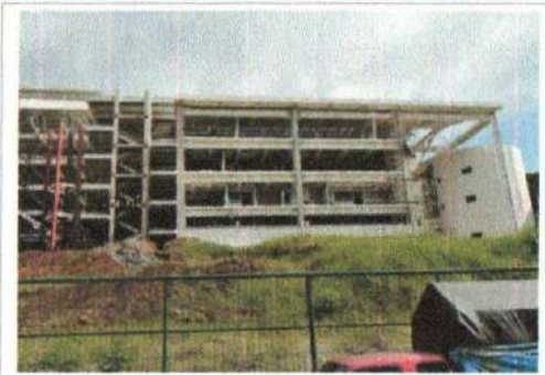
F1: Edificio A y E: Fachada Posterior
