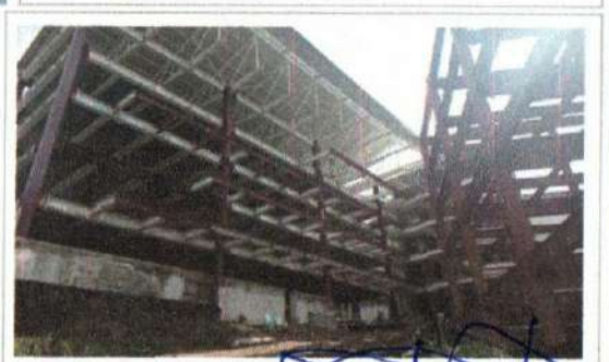
F5: Edificio C: Fachada Posterior
