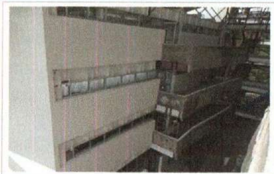
F2: Edificio A: Fachada Interior
