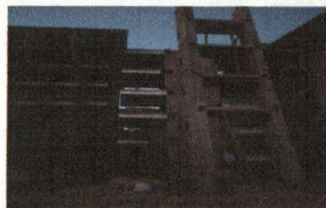
F4: Rampas de escaleras
