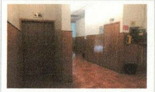
F4: Vista de pasillo interior
