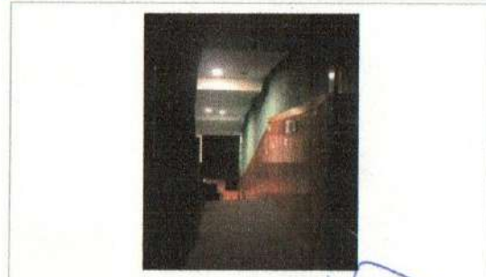
F5: Vista de pasillo a escaleras
