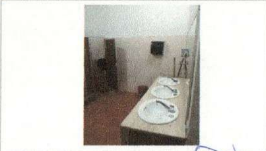
F5: Vista de sanitarios
