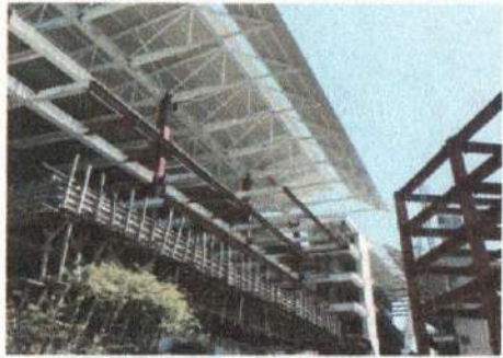
F1: Edificio (C) lateral
