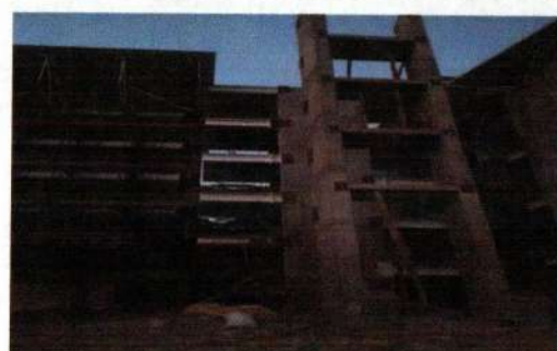
F4: Rampas de escaleras
