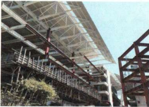
F1: Edificio (C) lateral
