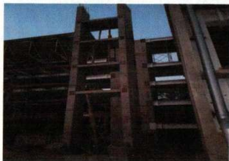
F3: Rampas de acceso
