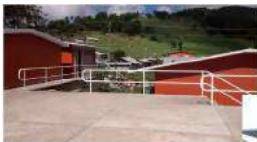
CONSTRUCCIÓN DE UN AULA DIDACTICA, REHABILITACIÓN DE EDIFICIOS Y OBRA EXTERIOR EN LA ESCUELA NIÑOS VERACRUZANOS EN EL MUNICIPIO DE ACAJETE
