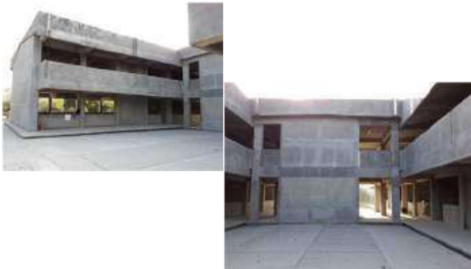
TERMINACION DE CONSTRUCCIÓN DE EDIFICIO "B" EN EL INSTITUTO TECNOLOGICO SUPERIOR DE CHICONTEPEC
