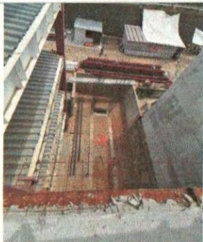
F3: Cimentación Cubo del elevador
