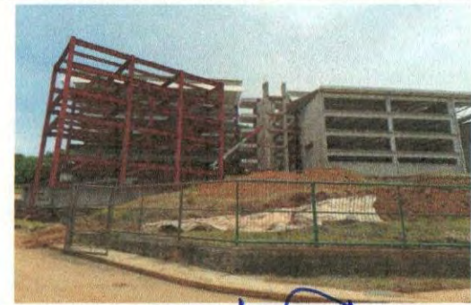
F5: Estructura principal cubo de escaleras y rampa
