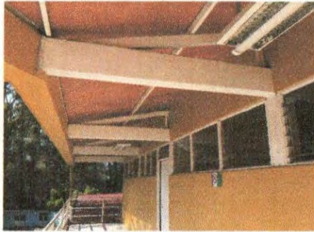
F1: Vista del acceso
