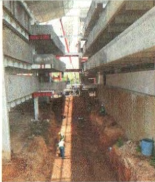
F1: Edificio (E) Rampe entre edificio A y D
