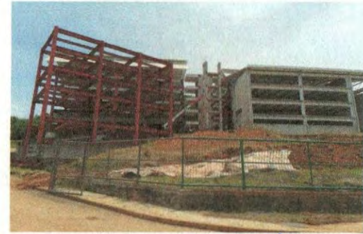
F5: Fachada principal cubo de escaleras y riego
