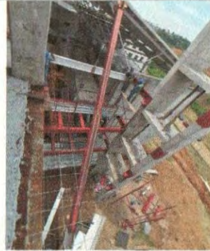
F2: Estructura escaleras
