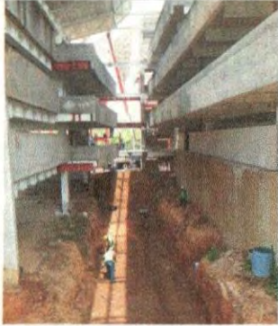
F1: Edificio (E) Rampa entre edificio A y D
