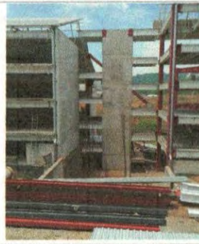
F4: Fachada posterior (cubo del elevador)
