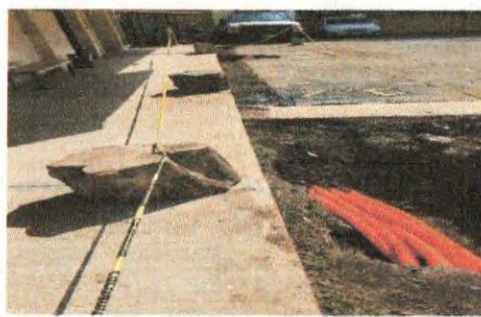
F4: Fachada lateral
