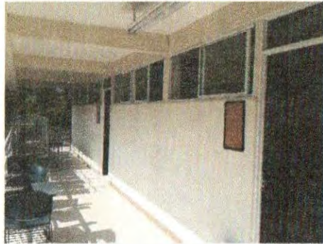
F1: Vista del acceso
