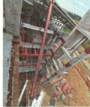
F2: Estructura escaleras
