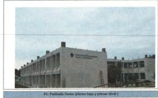
F4: Fachada Oeste (planta baja y primer nivel)
