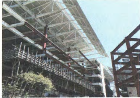
F1: Edificio (C) limpieza
