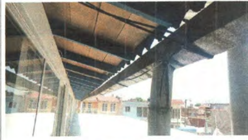
F2: Canales y cubierta planta alta
