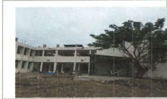
F2: Fachada este (planta baja y primer nivel)
