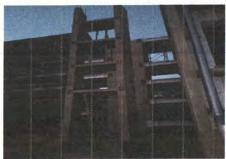
F3: Cimentación Rampas de acceso
