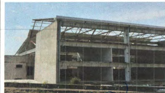
F5: Cubiertas edificio C
