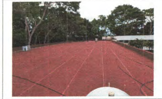
F2: Vista Oeste azotea edificio A
