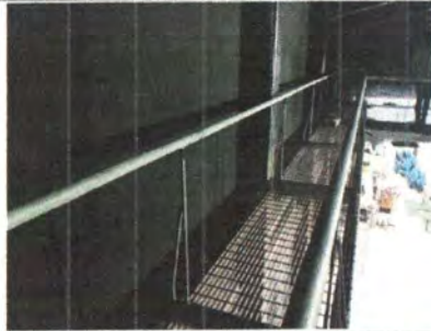
F1: Pasagatos lateral sobre muro de coincidencia
