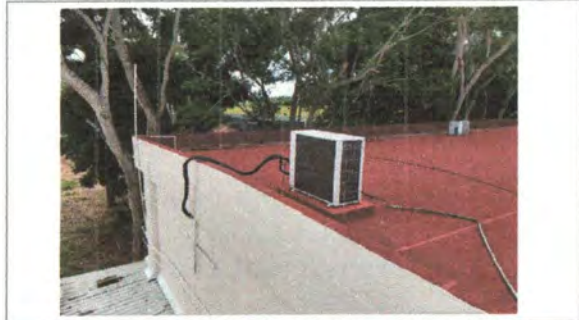
F1: Vista Sur azotea edificio A
