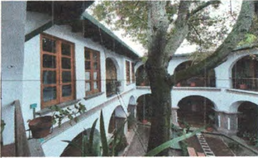
F3: Vista de vestíbulo de planta alta
