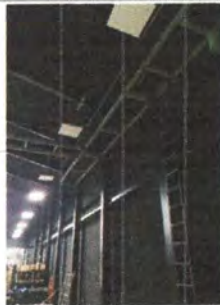
F3: Vista interior muro lateral de coincidencia
