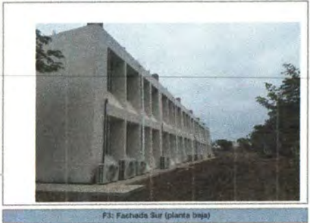
F3: Fachada Sur (planta baja)
