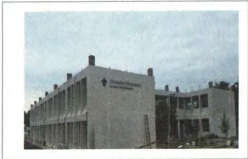
F1: Fachada norte (planta baja y primer nivel).
