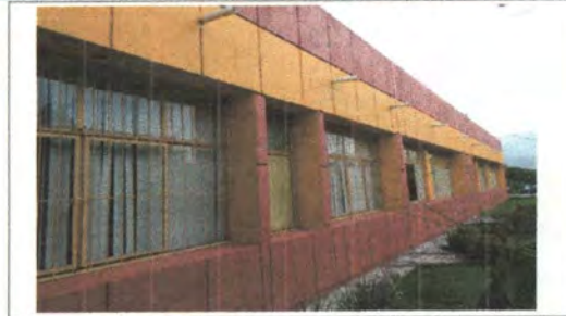
F2: Fachada Edificio A
