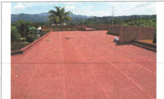
F3: Impermeabilización Edificio B
