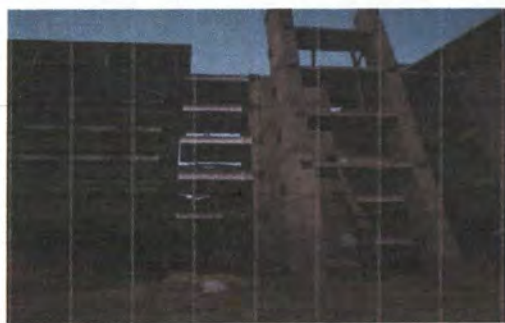
F4: Rampas de escaleras
