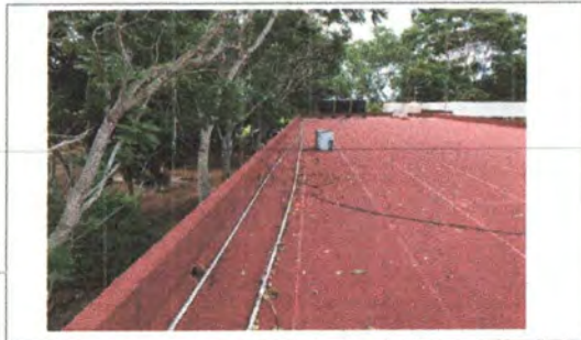
F3: Vista Oeste azotea edificio A
