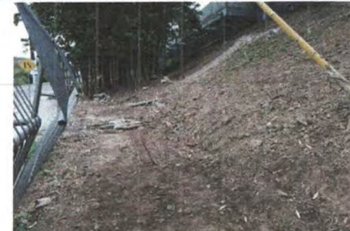
F5: Vista del área de los Biodigestores para tratamiento de aguas residuales
