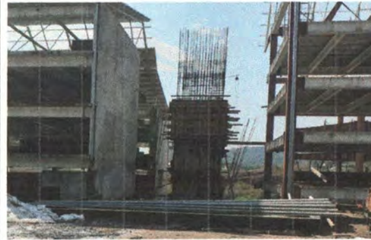
F2: Cimentación Escaleras
