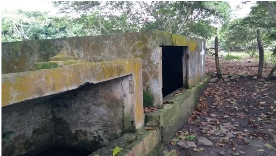
Imagen 14. Pozos de agua de la comunidad.
