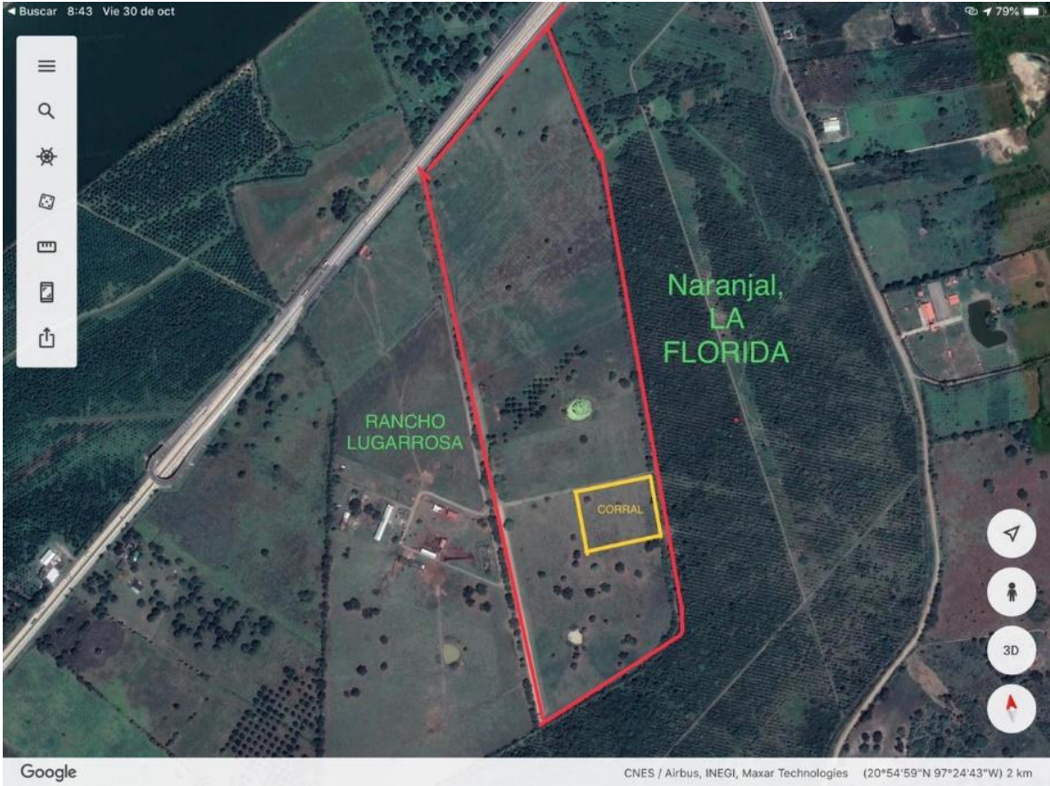
Figura 4. Vista aérea de la ubicación del Centro de Acopio.
