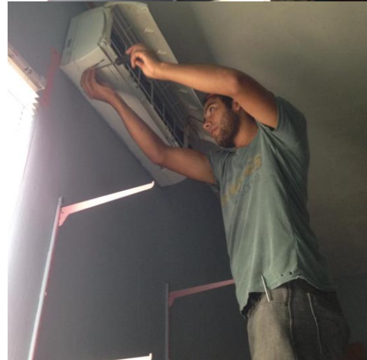
Fig. 17) Desatornillando y quitando carcasa.
