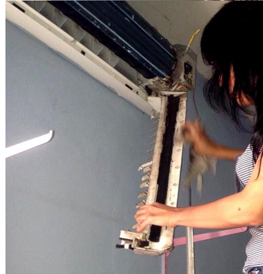
Fig. 19) Realizando la limpieza del equipo.
