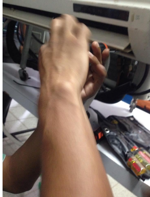
Fig. 1) Equipo de práctica en donde se puede apreciar la explicación en cómo se realiza el mantenimiento de un equipo de aire acondicionado. Se puede ver que el equipo está desenergizado, al momento de desatornillarlo para poder darle la limpieza. Podemos también apreciar el evaporador y las tarjetas de alimentación.
