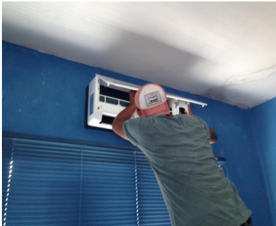
Fig. 15) Limpieza finalizada, colocando la carcasa con precaución.
