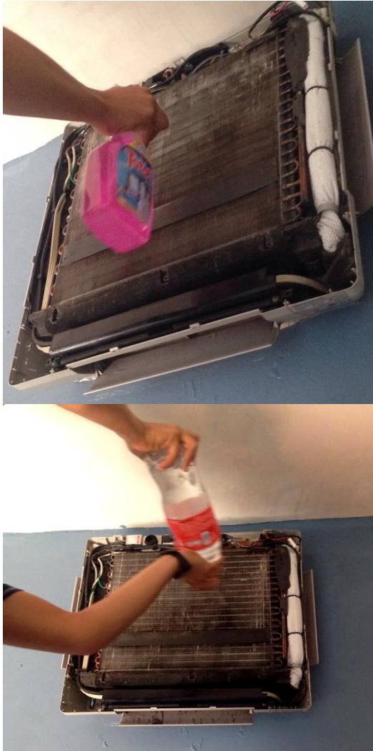
Fig. 4) Llevando a cabo la limpieza con el líquido y enjuagando con agua.
