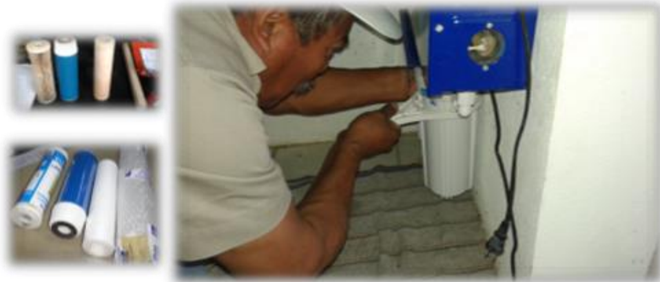
13 Cambio de Filtros y Lámpara UV
