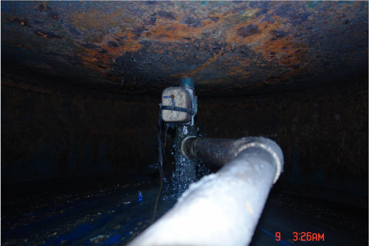
Foto 1; Conexión de la tubería de alimentación de la unidad de Digestión Anaerobia
