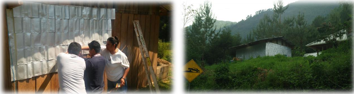
Fig. 8 Forrado de cafetería con material Tetrabrick
