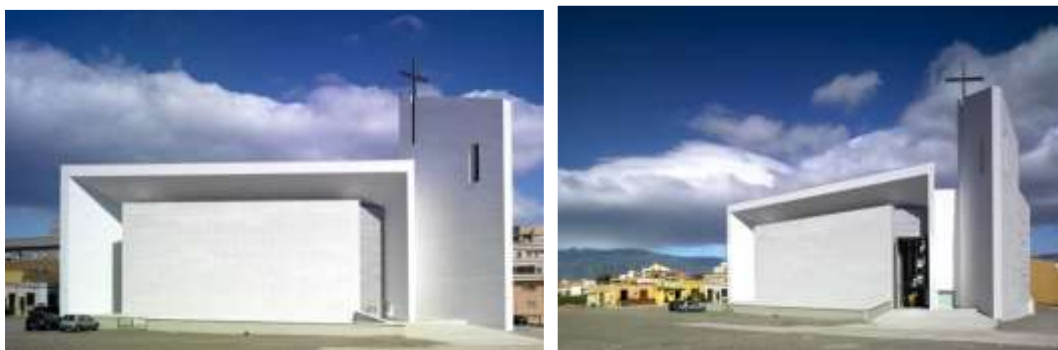
Figura 7. Fachadas de la iglesia de Santa Ana y San Joaquín. RGRM Arquitectos. Granada, España.
