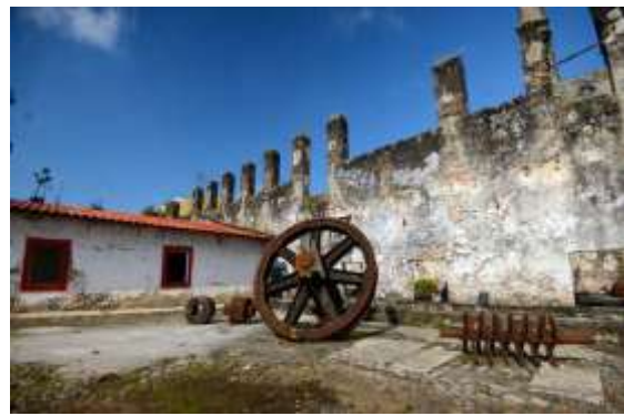
Ilustración 15. Patio exterior vista 1 de ex-hacienda San Francisco Toxpan.
