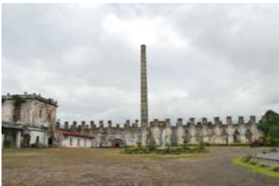
Ilustración 16. Patio exterior vista 2 de ex-hacienda San Francisco Toxpan.
