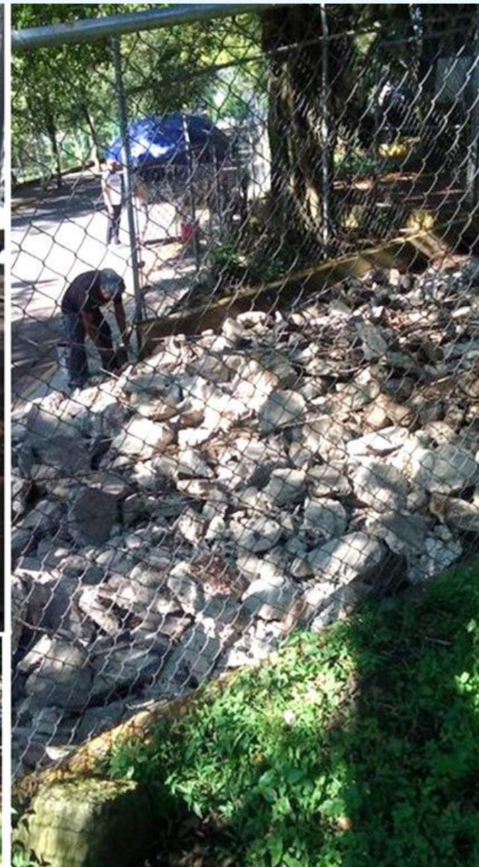
Demolición de rampa sobre el acceso Principal del Estacionamiento; que se encontraba hundido y Fracturado.
