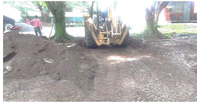
Tendido de escoria para el estacionamiento.
