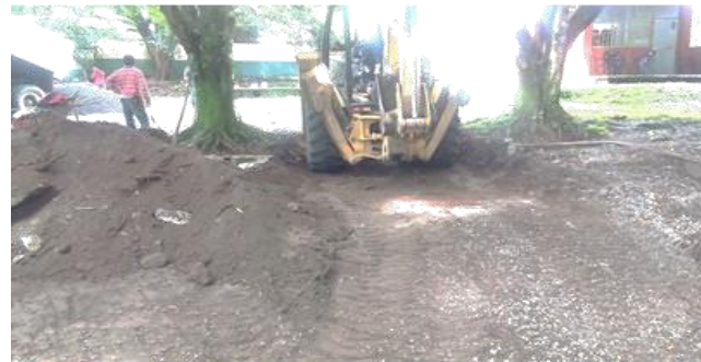
Tendido de escoria para el estacionamiento.
