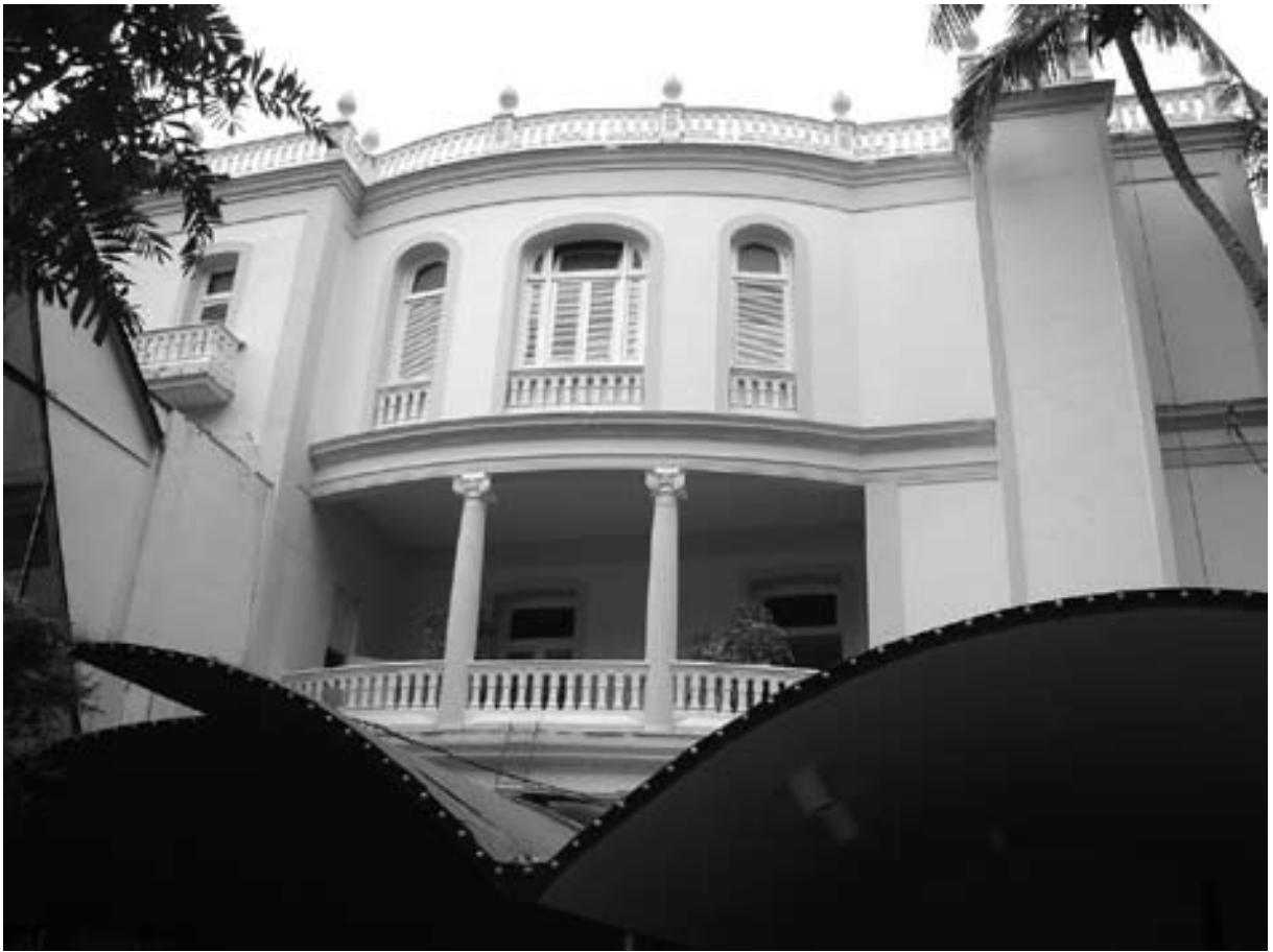
Foto 02: Tropicana, edificio original y marquesina de entrada al frente.
