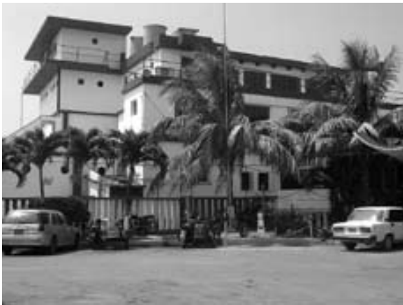
Foto 05: club nautico, edificio original.
