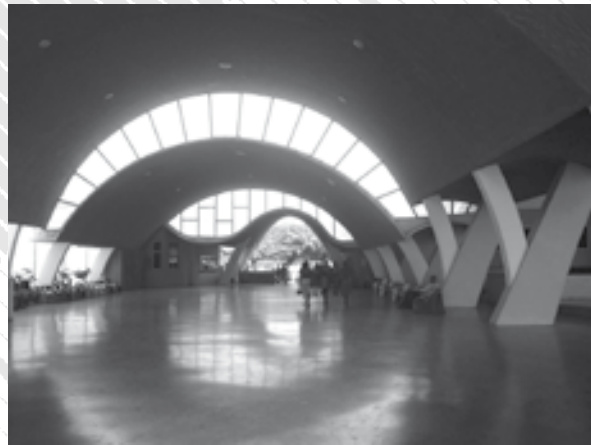
Foto 07: Club náutico, unión de las cáscaras con lienzos de vidrio para permitir el paso de la luz y aligerarla.
