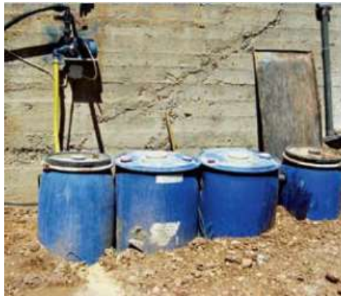
FIGURA 6.7 TANQUES DE PLÁSTICO DE 220 LITROS, SE UTILIZAN TAMBIÉN COMO FILTRO ANAEROBIO EN JORDANIA.
