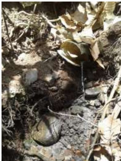
FIGURA 5.2 TUBO DE SALIDA DE AGUAS GRISES DE LA CALLE GARDENIAS
