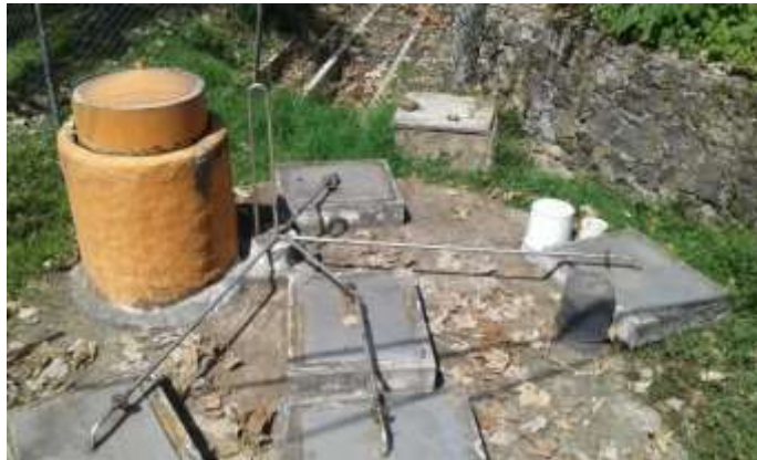
FIGURA 5.3 BIODIGESTOR DE LA CALLE BUGAMBILIAS EN LA COLONIA MARIANO ESCOBEDO
