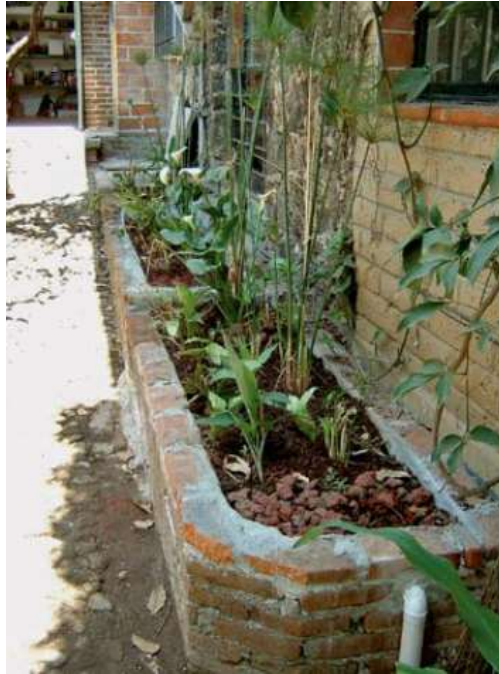
FIGURA 6.2 ENTRAMADO DE RAÍCES PARA LAS AGUAS GRISAS DE UNA VIVIENDA EN TEPOZTLÁN, MÉXICO. FUENTE: GREYWATER MANAGEMENT (MOREL & DIENER, 2006).
