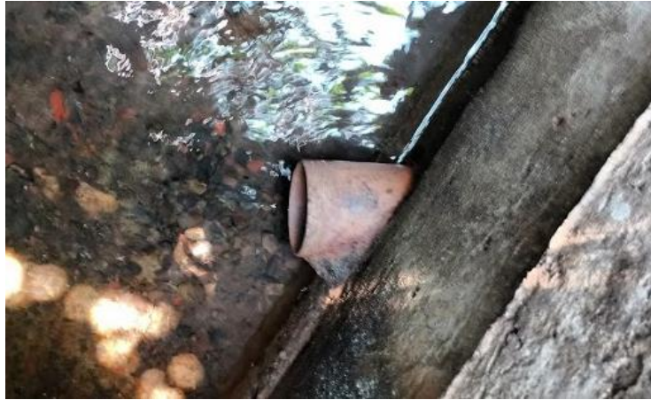
Figura 32. Nivel del agua por debajo del tubo de la caja captadora (punto 2)
