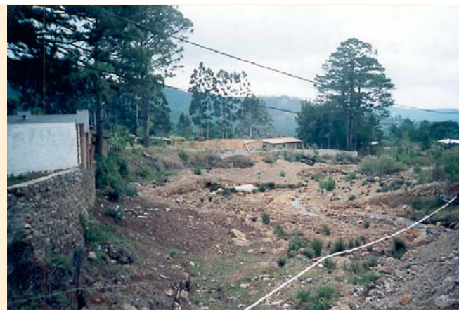
La Quebrada Agua Amarilla tiene una alta velocidad de socavación, un caudal pico considerable y drena por donde hay mayor concentración de población, lo que causa graves daños a la infraestructura.
