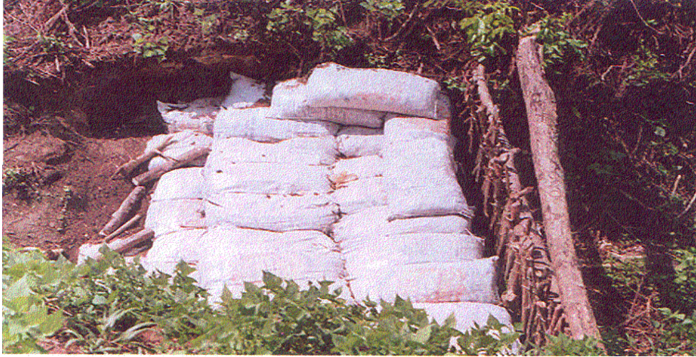
Figura 3. Represa construida con bultos de tierra y estacado de protección, Pijijiapan, Chis.
