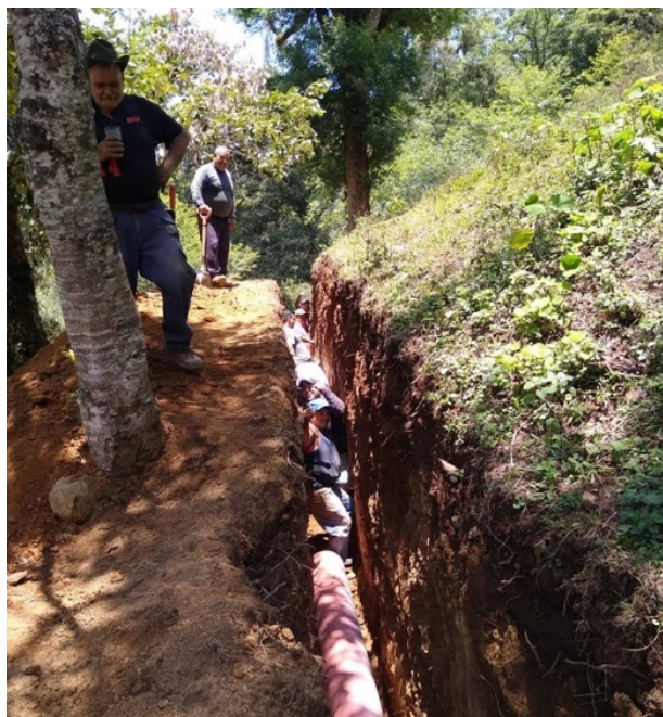
Figura 17. Faeneros colaborando en la colocación de la tubería para sanear el río Naolinco (junio de 2022).
