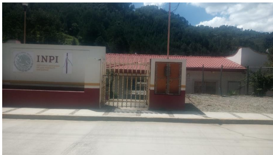
Figura 6. Albergue Municipal. Elaboración propia.
