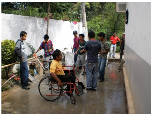
Foto 8: Construcción de las rampas.
